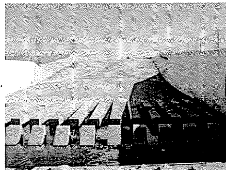
Prado Lake Spillway
