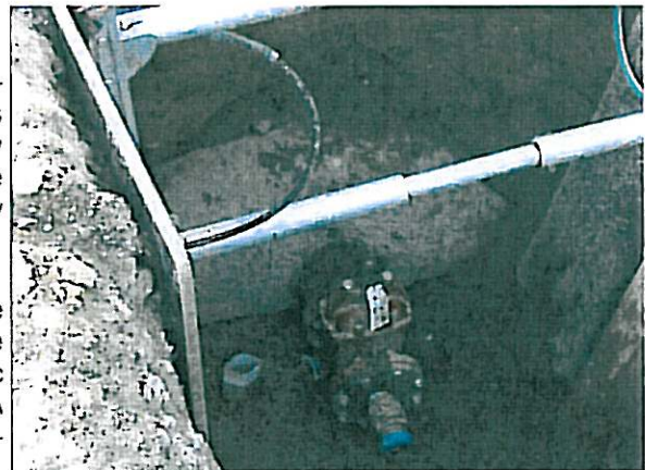
Frito Lay, CVWD
